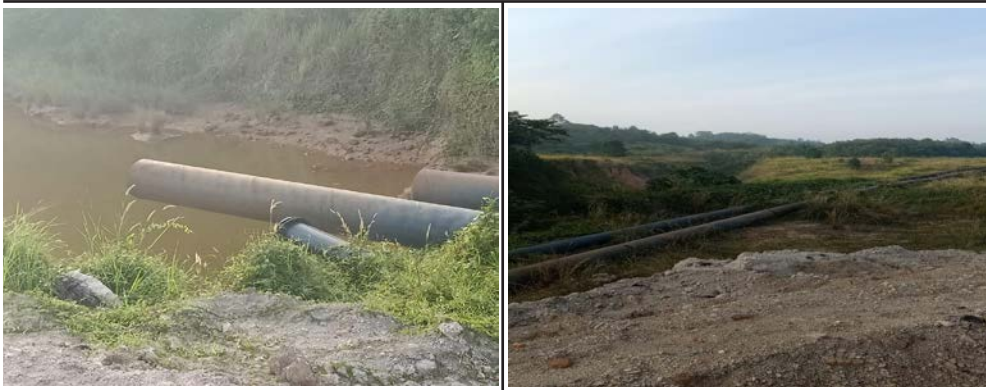
Gambar 12. Pengalihan Aliran Sungai Penimur menggunakan Pompa
